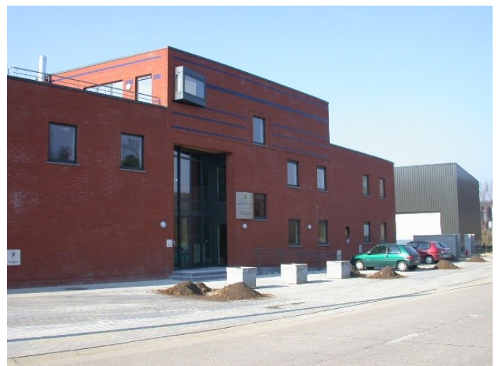
Service Travaux Avenue de Veszprem, 5 Avenue Georges Lemaitre
